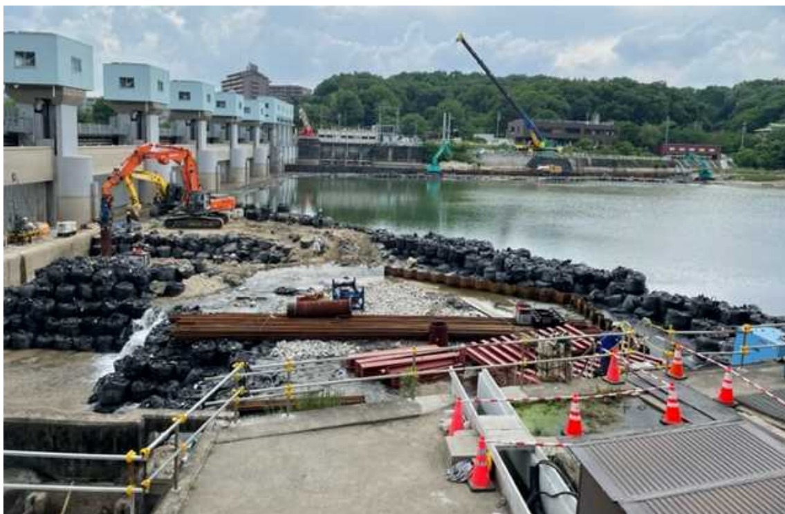
頭首工全景（左岸側から撮影）
