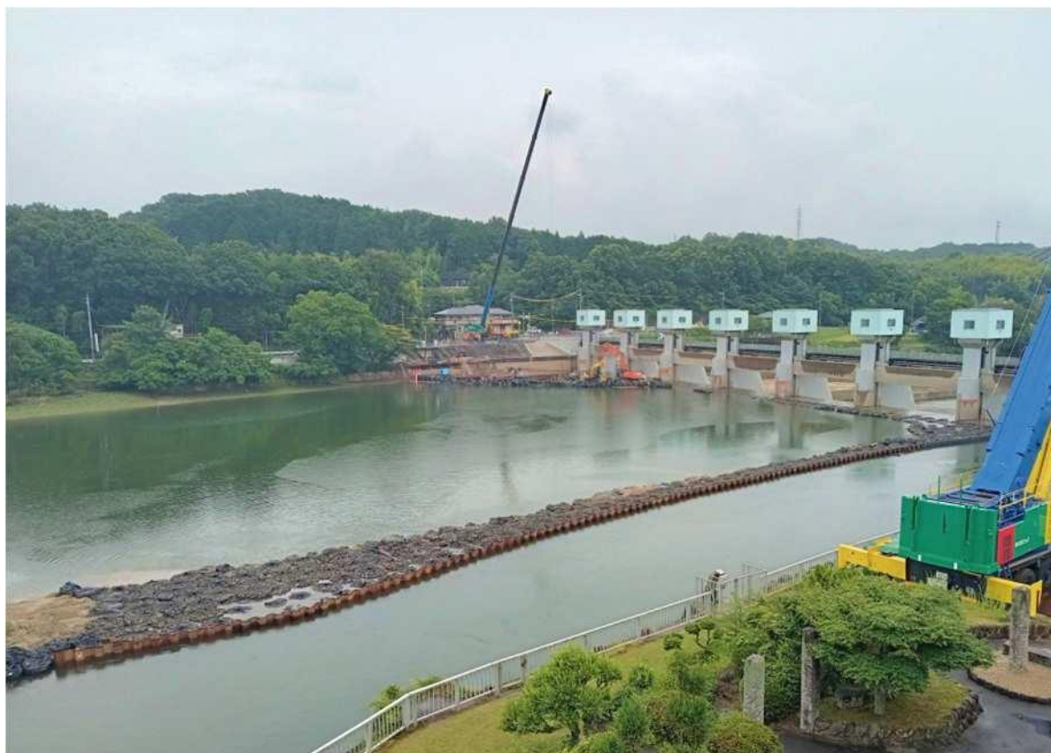
頭首工全景（右岸側から撮影）
