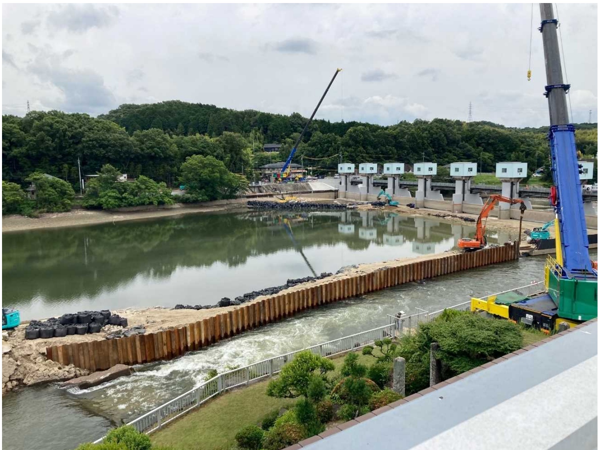
頭首工全景（管理所側から撮影）
