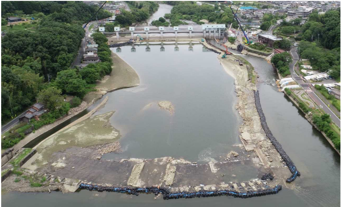
頭首工全景（上流から撮影）
