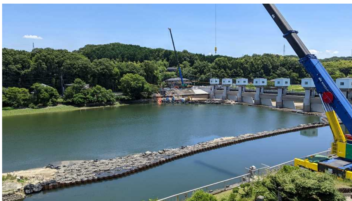
頭首工全景（右岸側から撮影）
