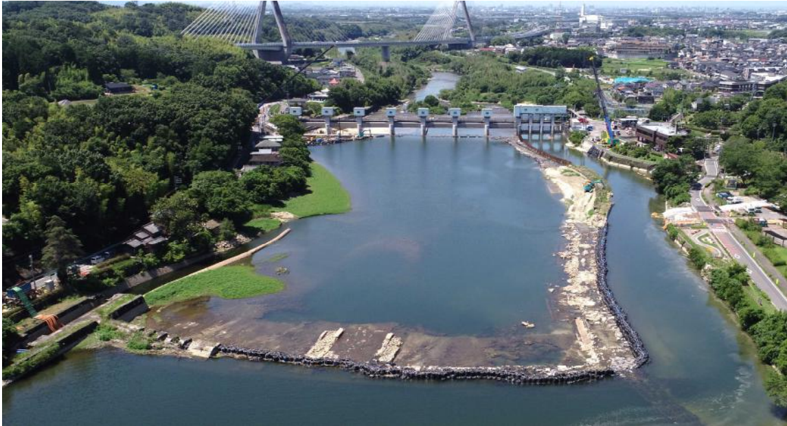
頭首工全景（上流から撮影）
