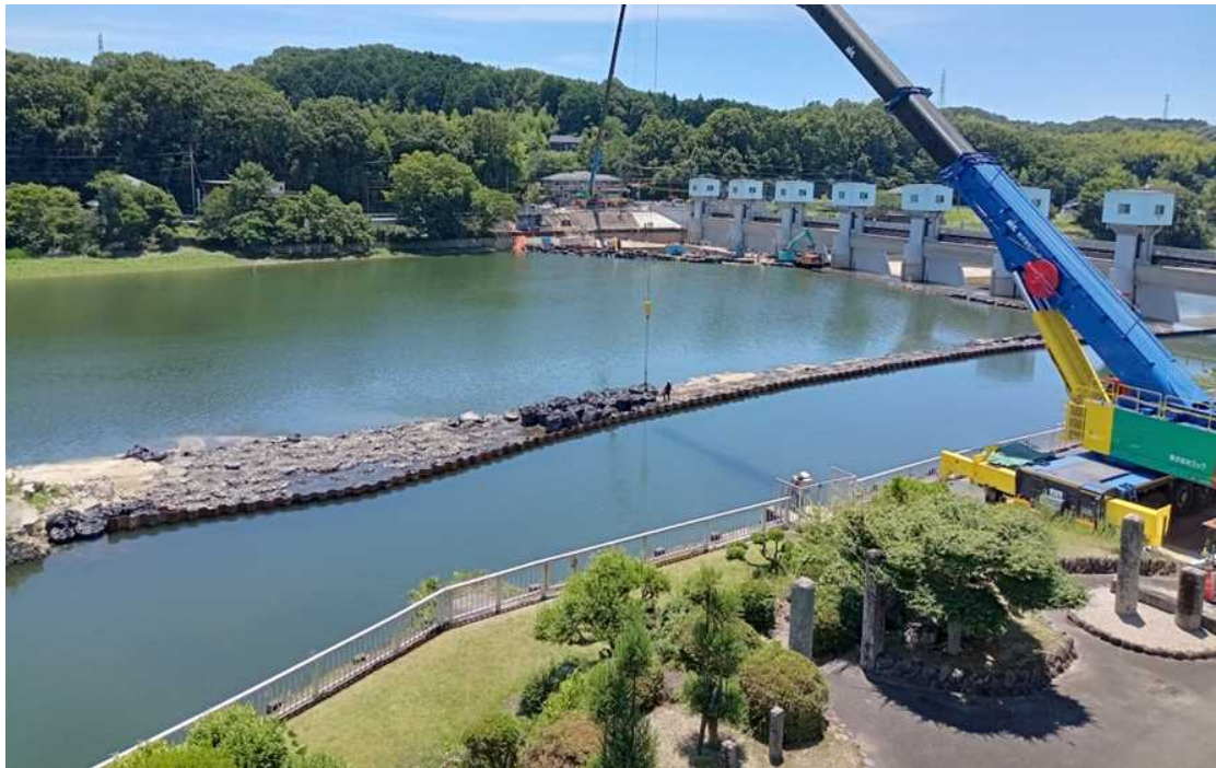
頭首工全景（右岸側から撮影）
