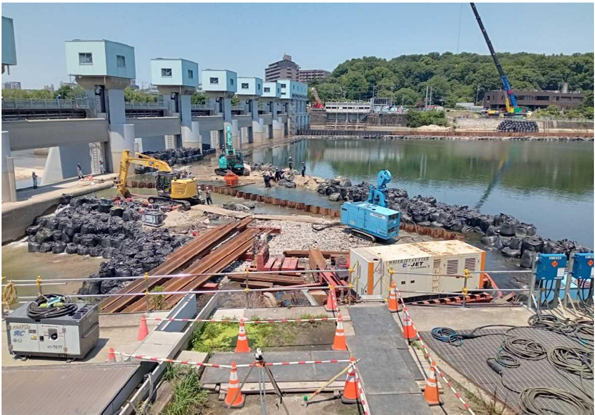
頭首工全景（左岸側から撮影）
