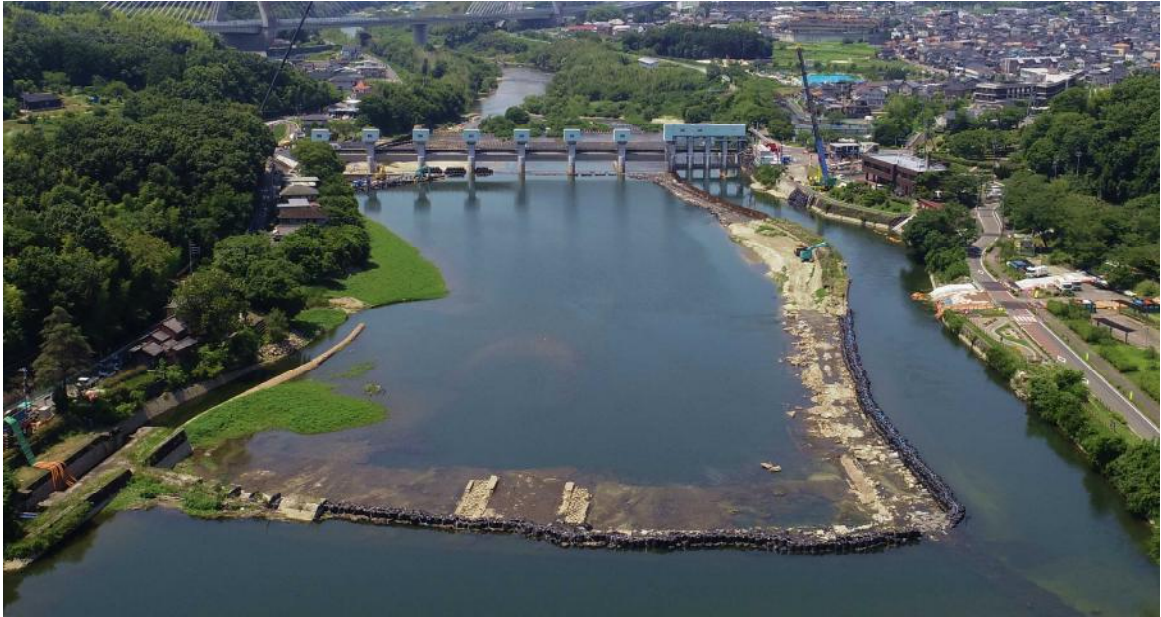
頭首工全景（上流から撮影）
