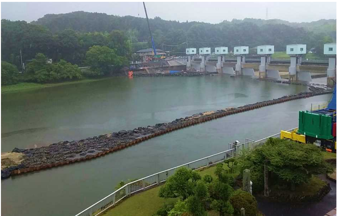
頭首工全景（右岸側から撮影）
