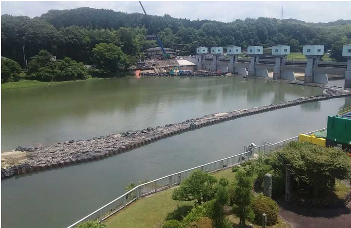
頭首工全景（右岸側から撮影）
