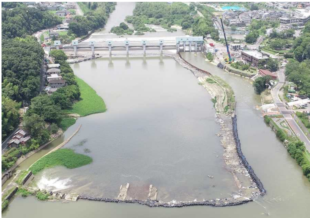
頭首工全景（上流から撮影）
