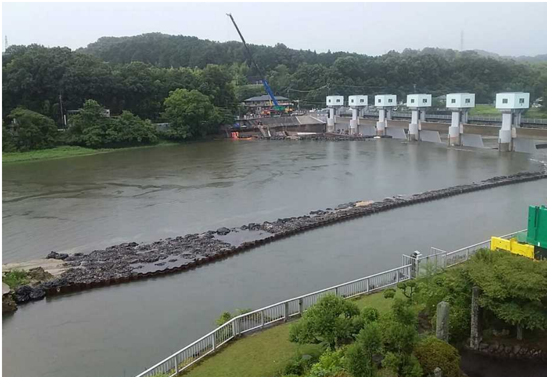
頭首工全景（右岸側から撮影）
