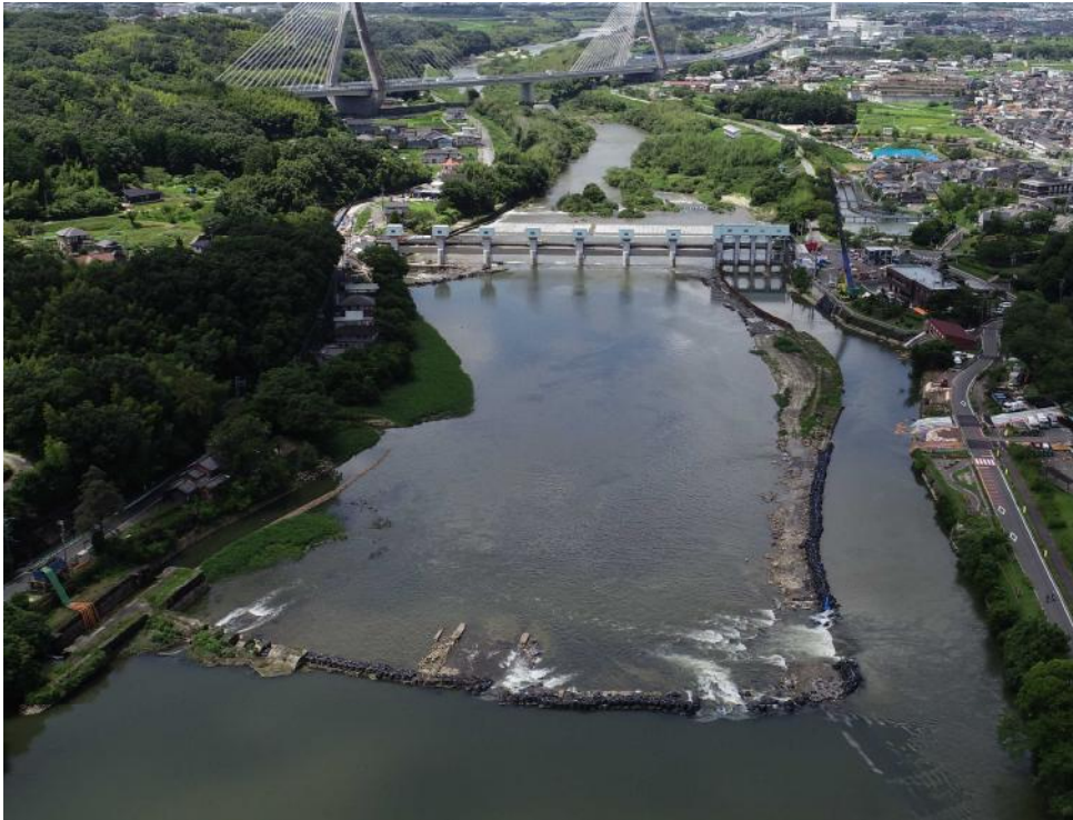
頭首工全景（上流から撮影）
