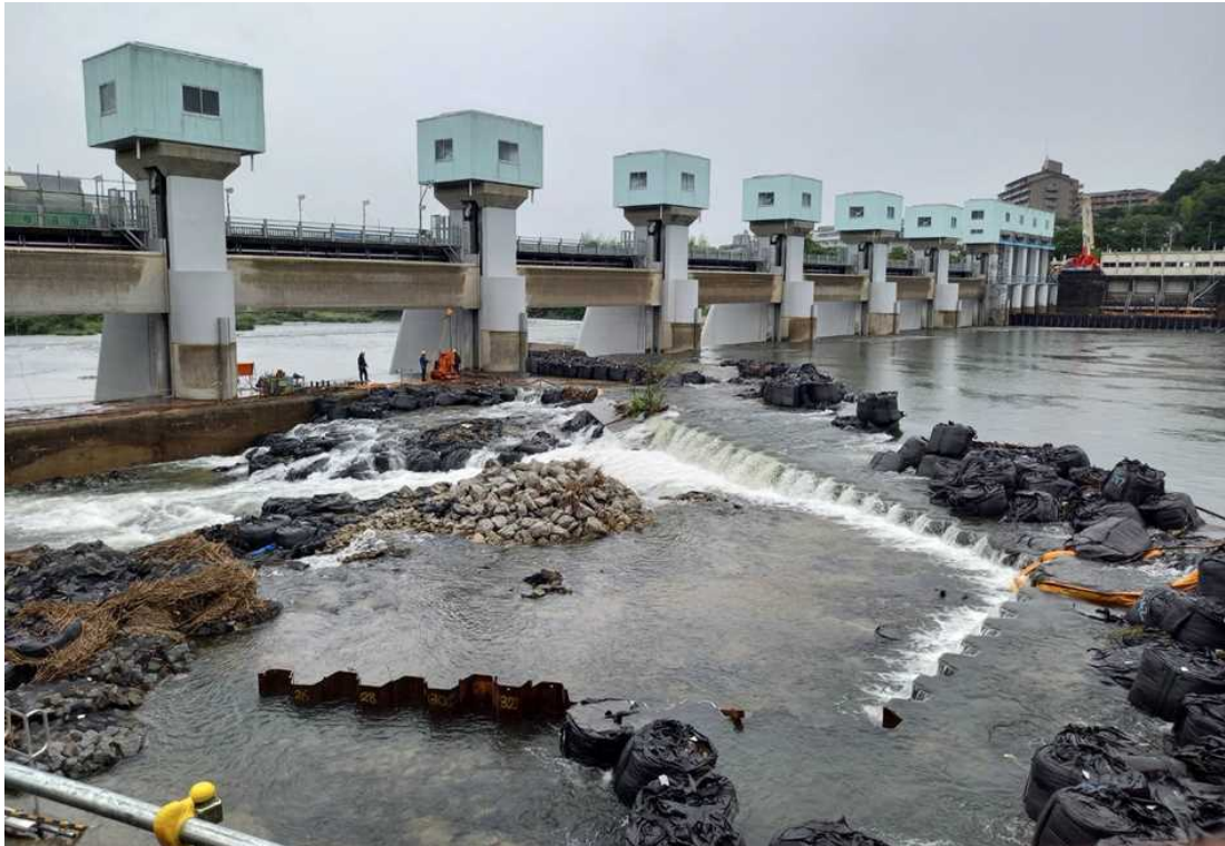
頭首工全景（左岸側から撮影）
