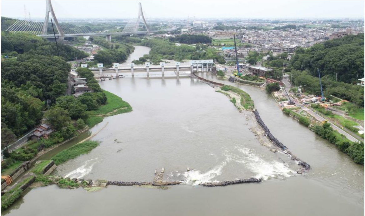
頭首工全景（上流から撮影）
