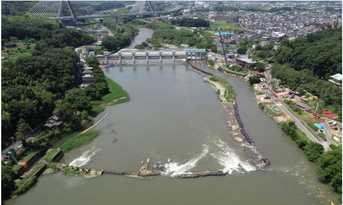
頭首工全景（上流から撮影）
