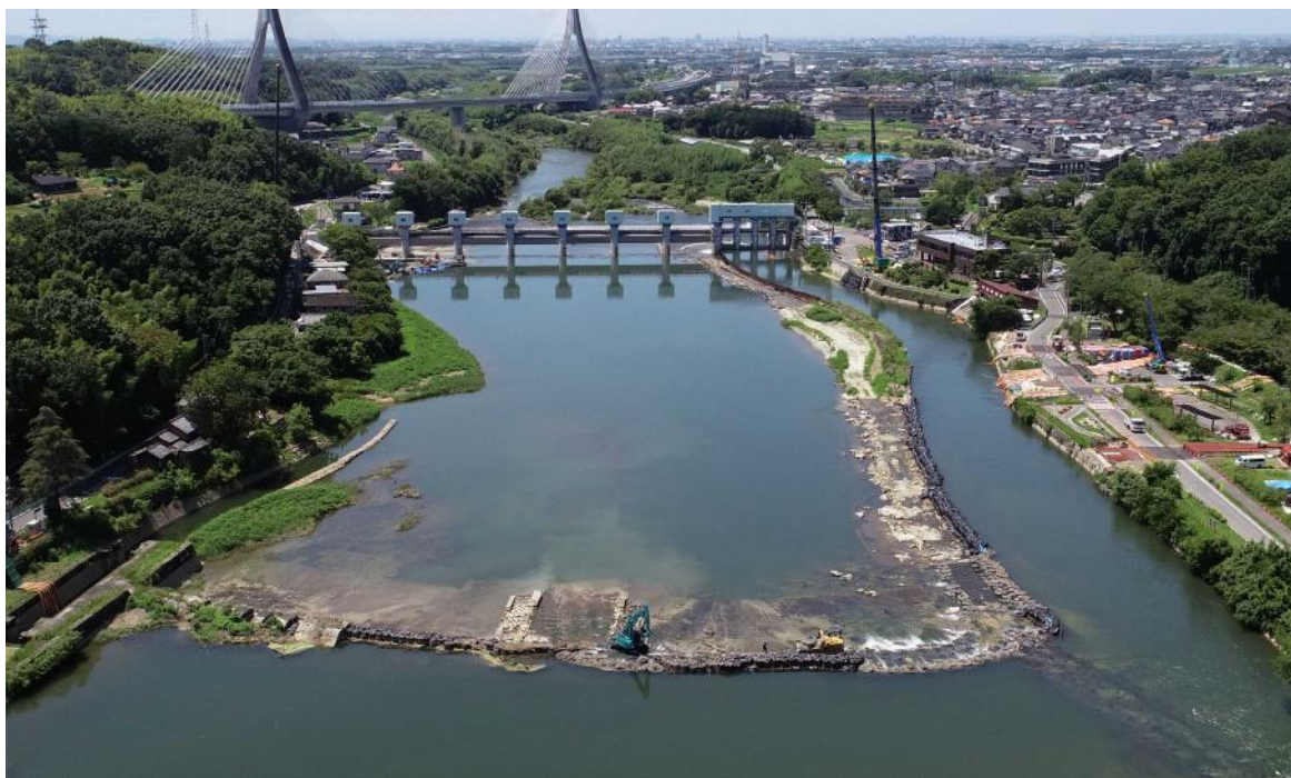
頭首工全景（上流から撮影）
