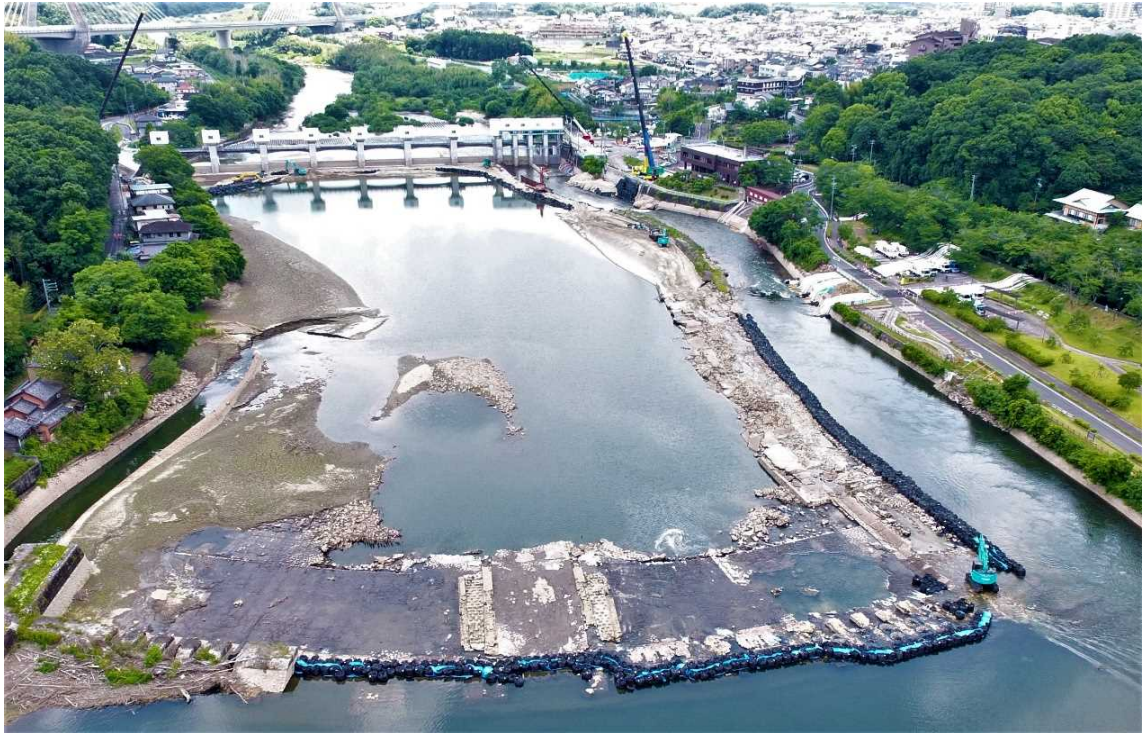
頭首工全景（上流から撮影）
