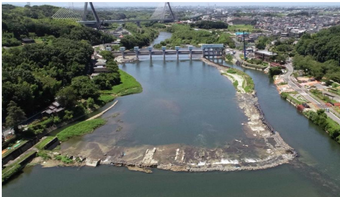
頭首工全景（上流から撮影）
