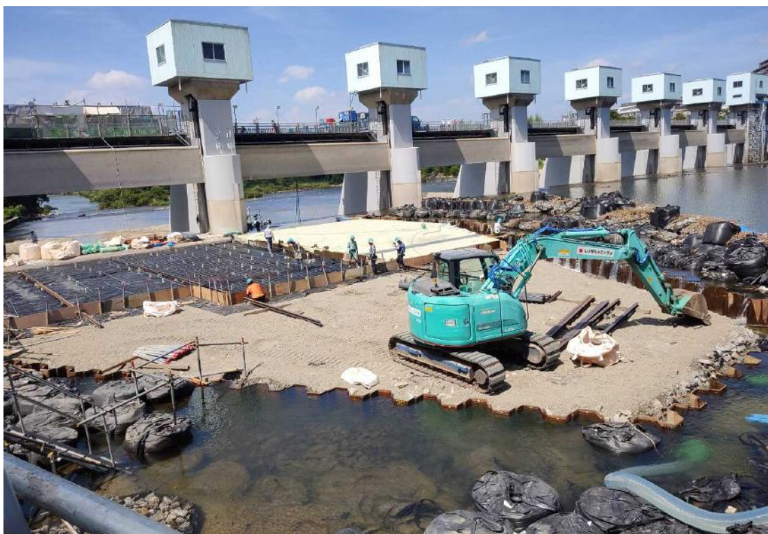
頭首工全景（左岸側から撮影）
