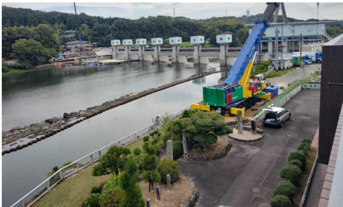
頭首工全景（右岸側から撮影）
