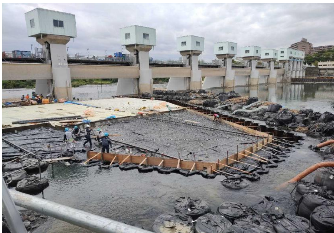
頭首工全景（左岸側から撮影）
