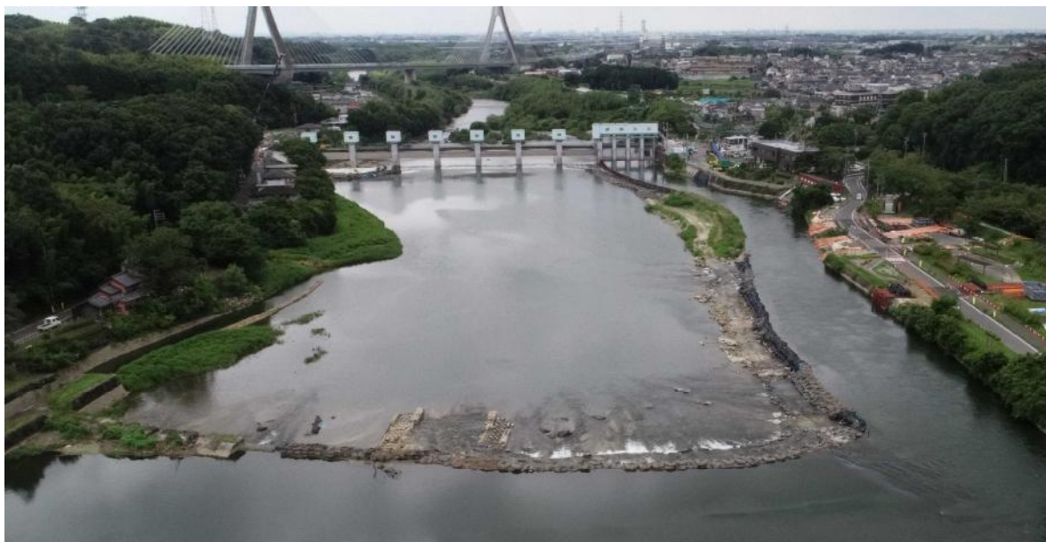
頭首工全景（上流から撮影）
