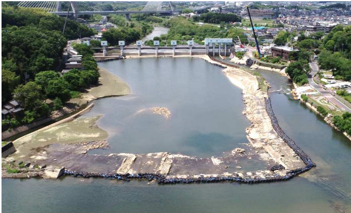
頭首工全景（上流から撮影）
