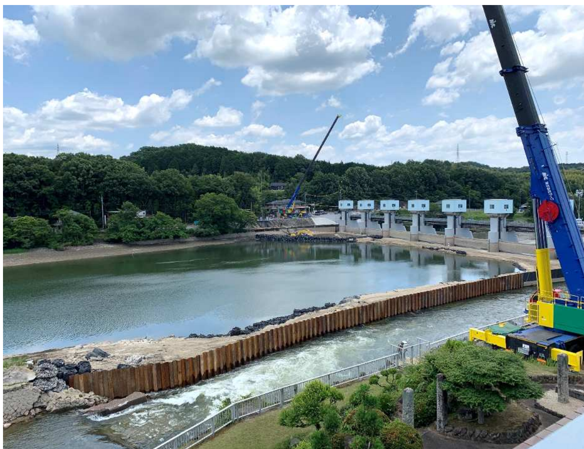
頭首工全景（管理所側から撮影）
