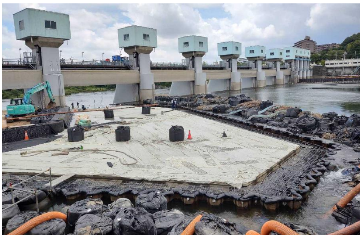
頭首工全景（左岸側から撮影）
