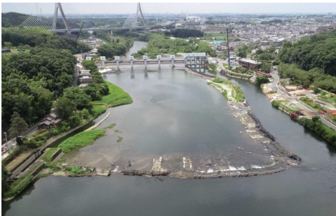
頭首工全景（上流から撮影）
