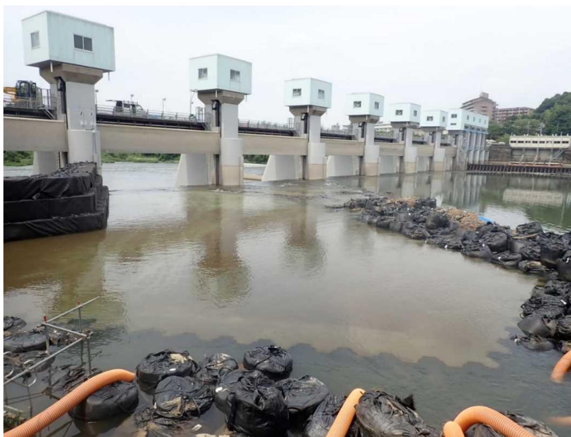
頭首工全景（左岸側から撮影）
