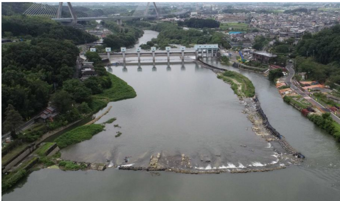
頭首工全景（上流から撮影）
