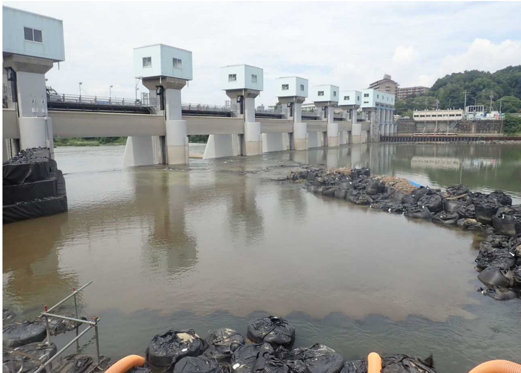
頭首工全景（左岸側から撮影）
