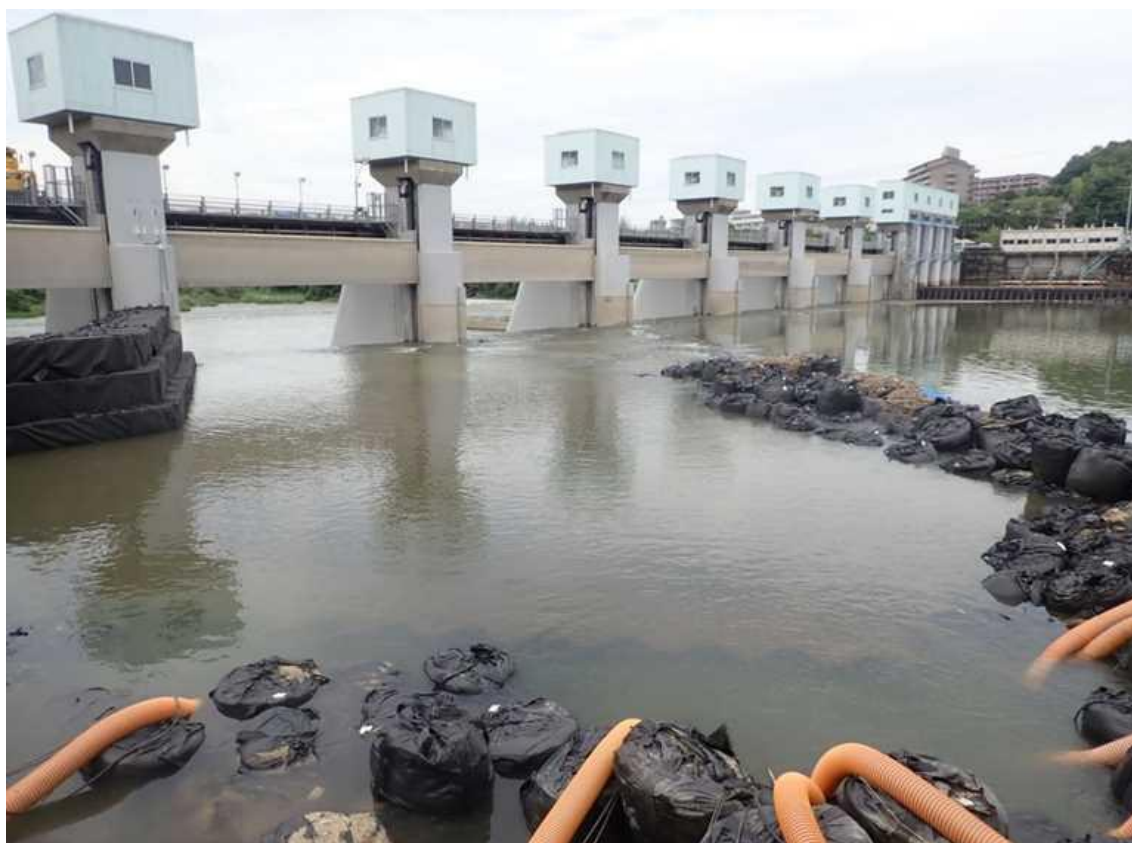
頭首工全景（左岸側から撮影）
