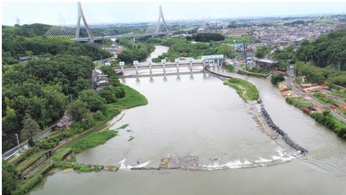
頭首工全景（上流から撮影）
