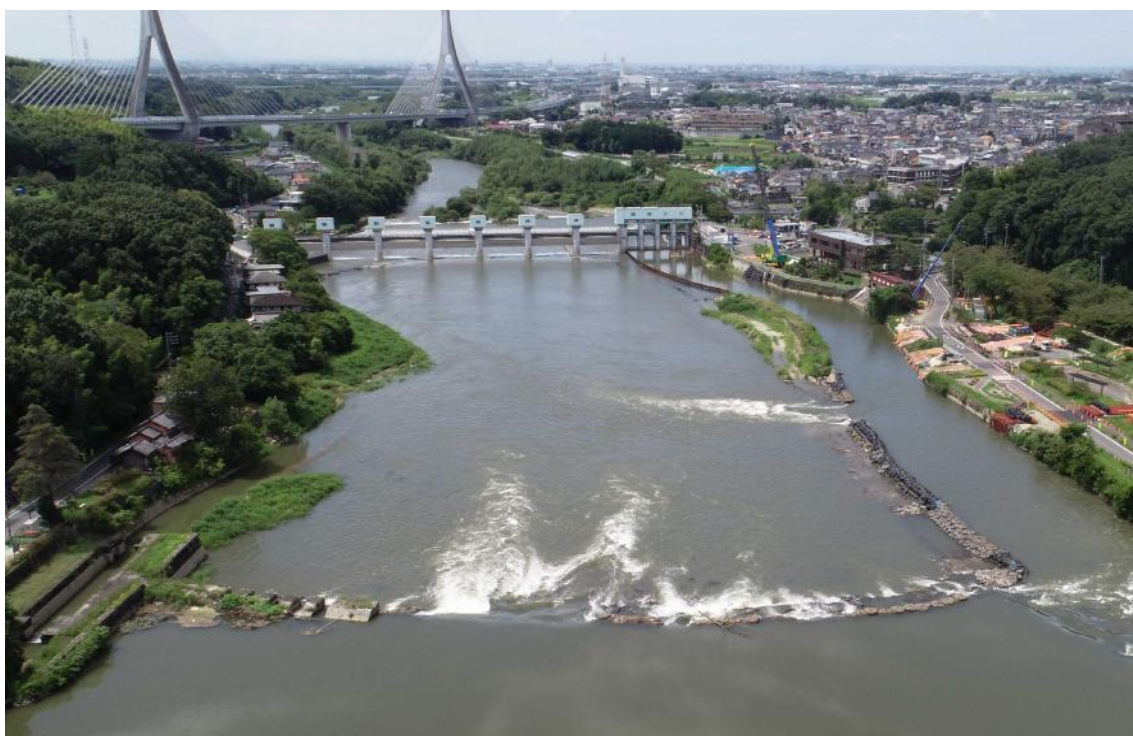
頭首工全景（上流から撮影）
