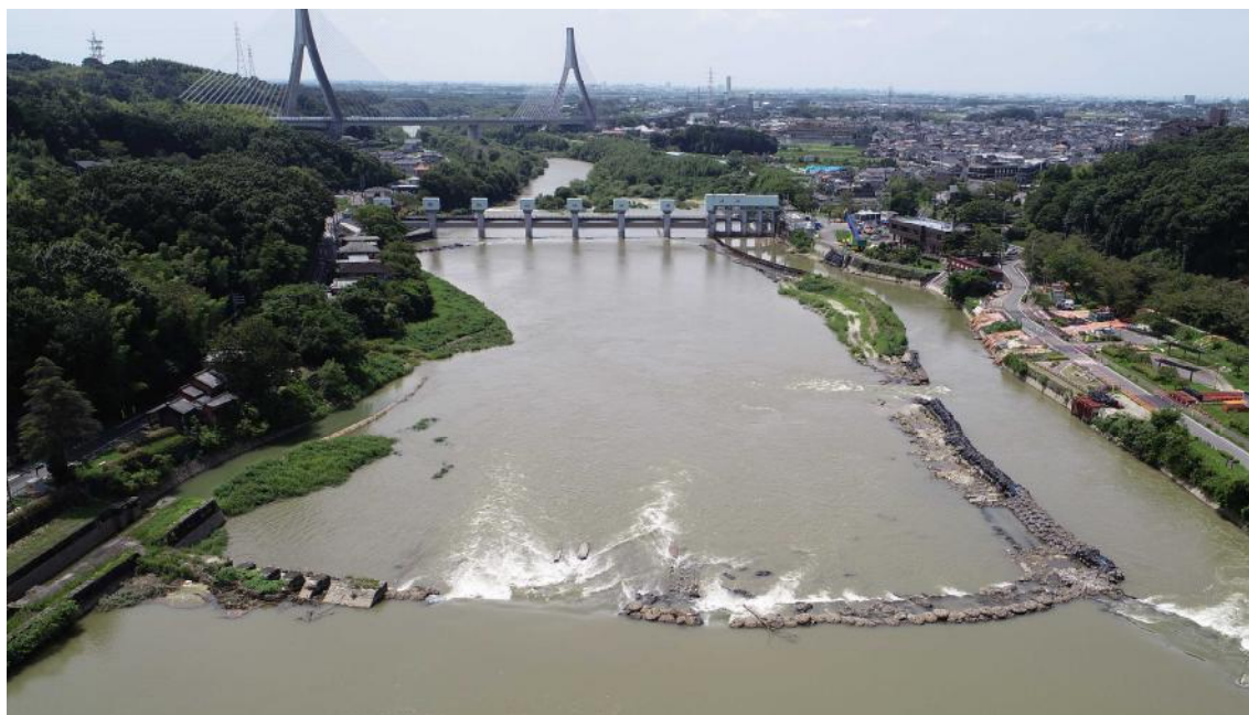
頭首工全景（上流から撮影）
