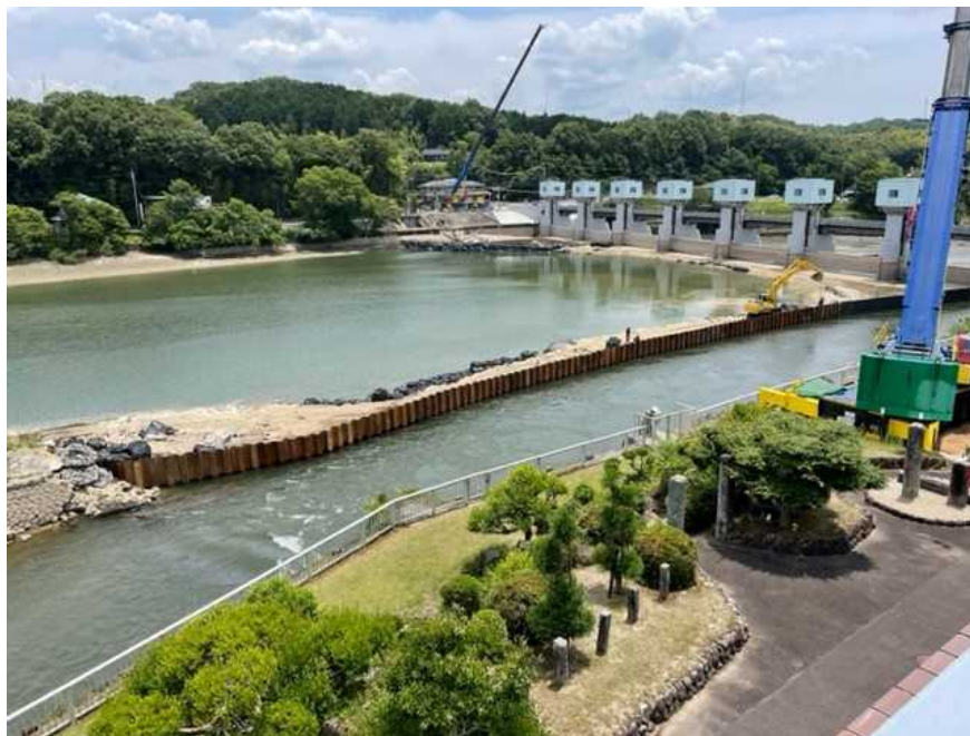
頭首工全景（管理所側から撮影）
