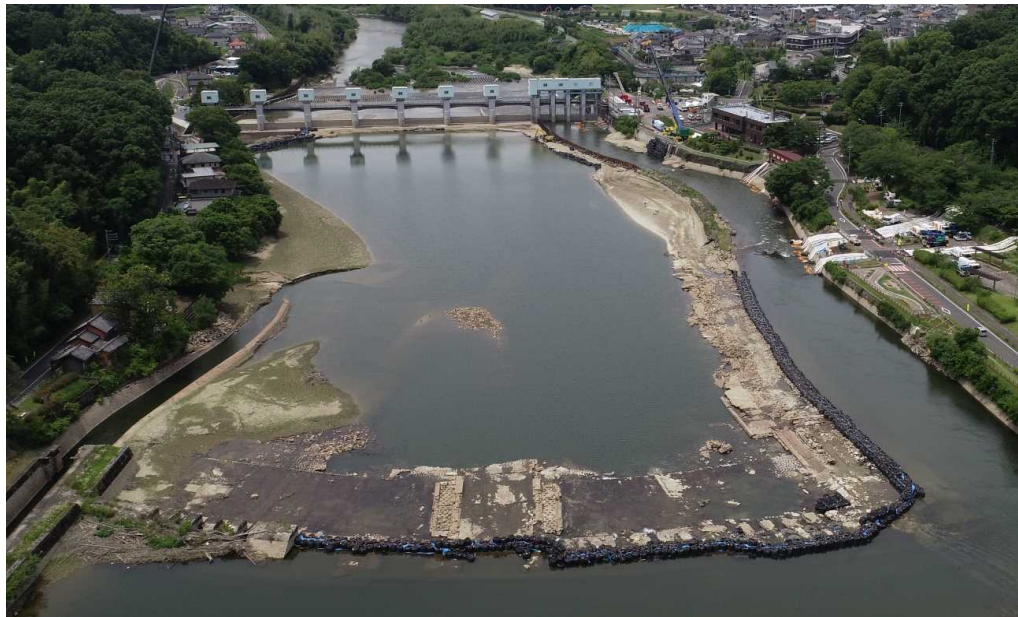
頭首工全景（上流から撮影）
