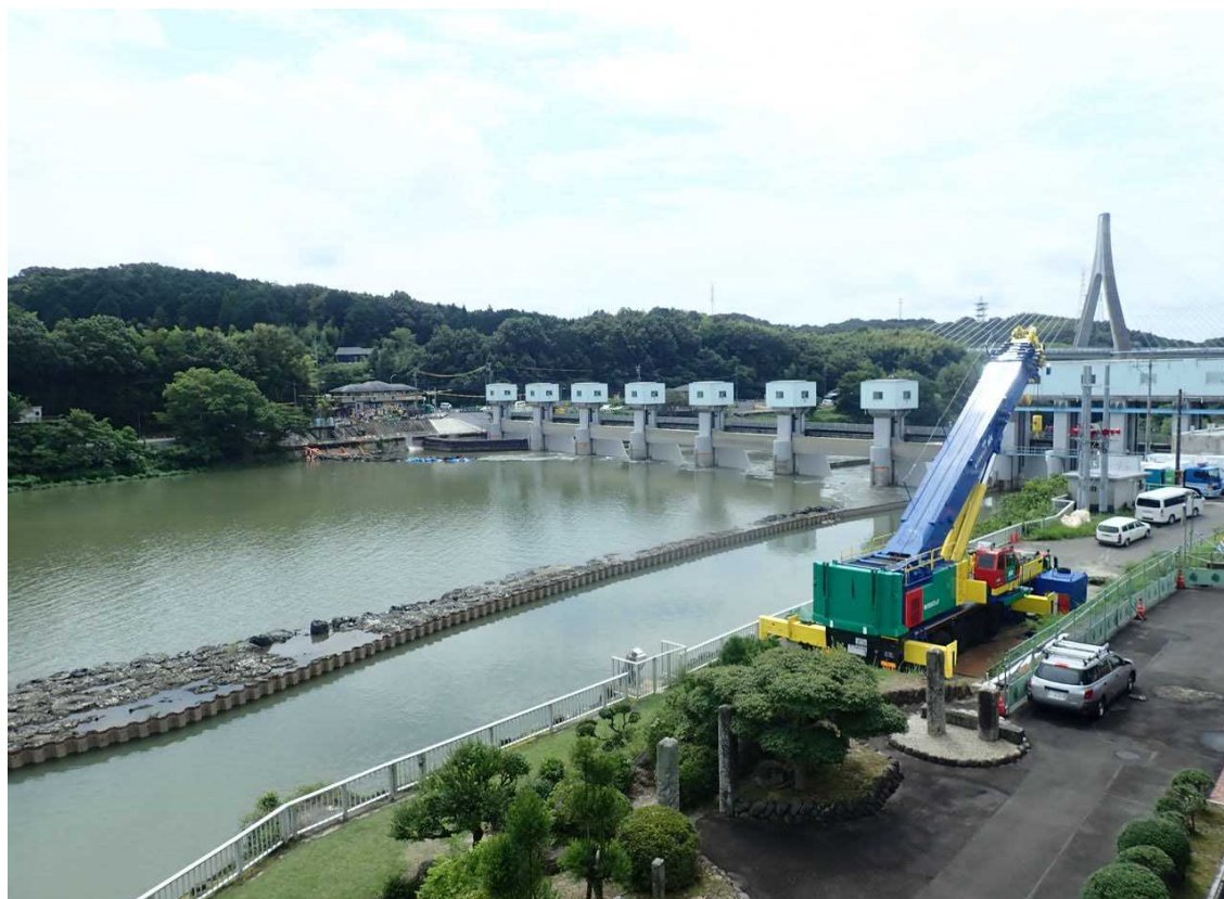
頭首工全景（右岸側から撮影）
