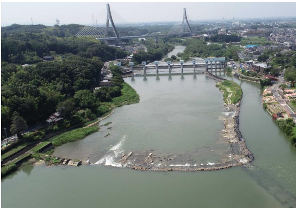
頭首工全景（上流から撮影）
