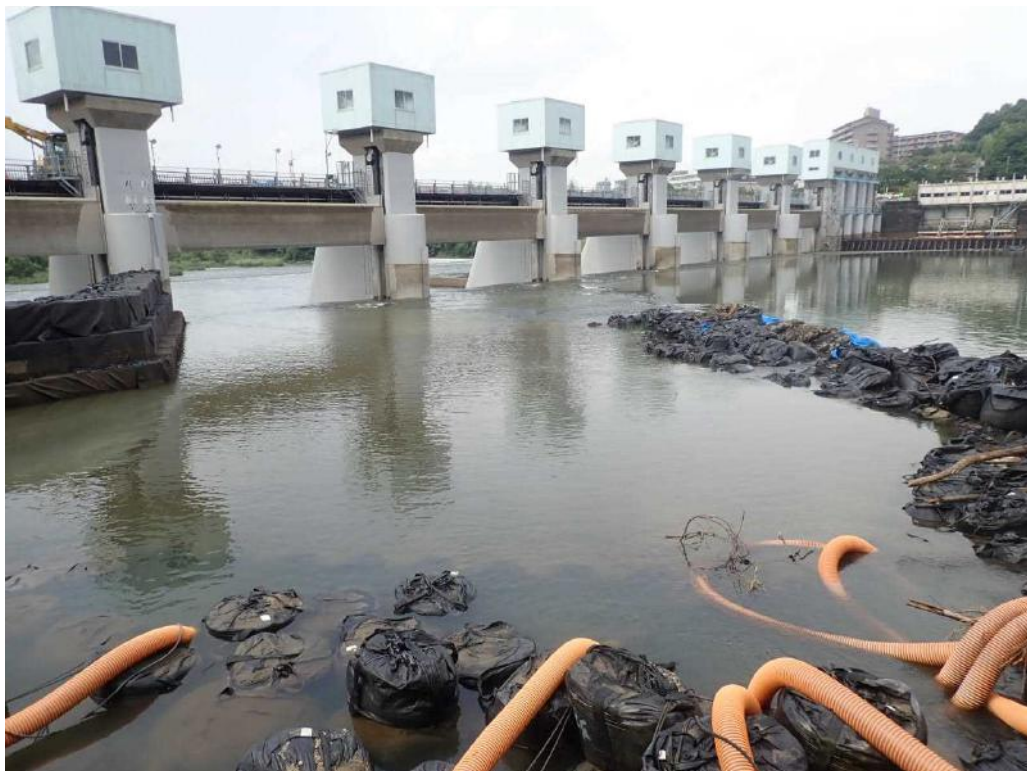
頭首工全景（左岸側から撮影）
