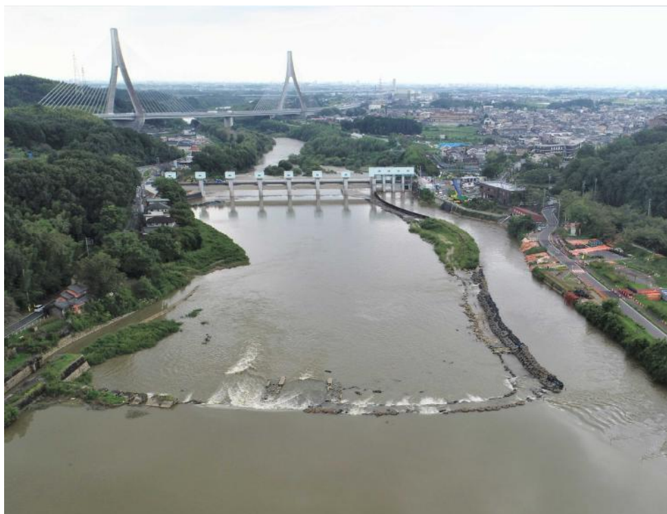
頭首工全景（上流から撮影）
