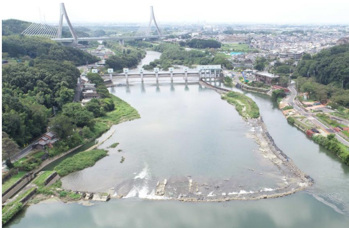
頭首工全景（上流から撮影）
