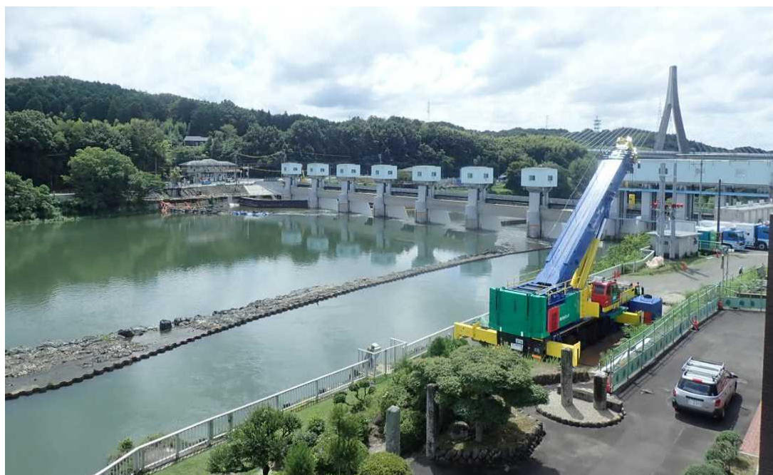
頭首工全景（右岸側から撮影）
