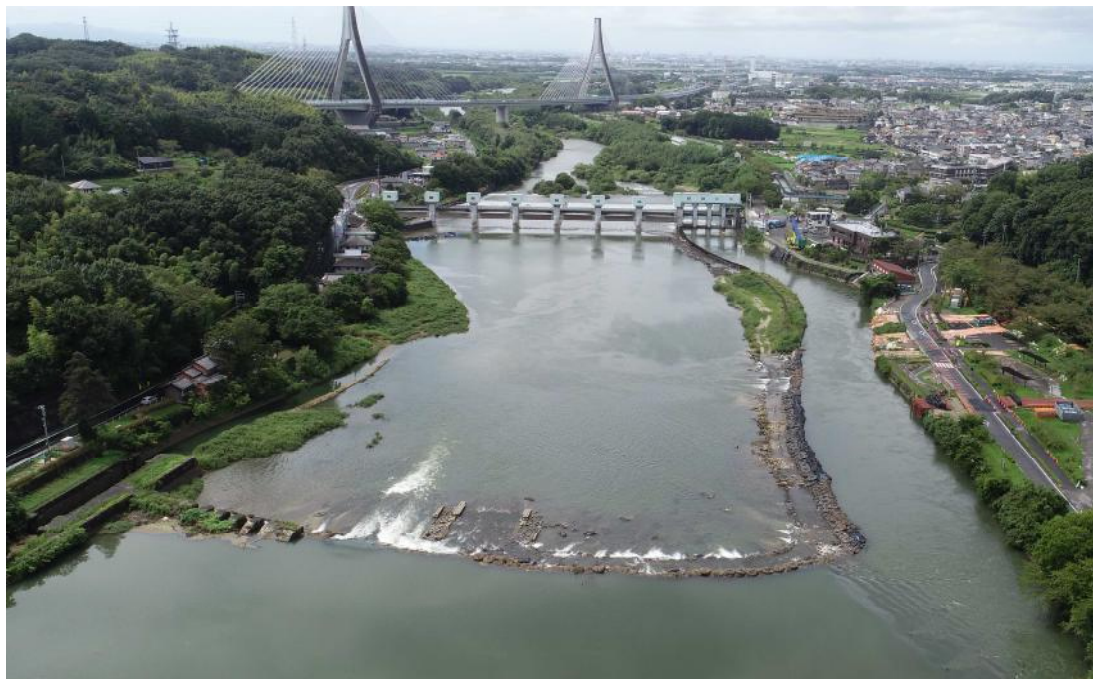
頭首工全景（上流から撮影）
