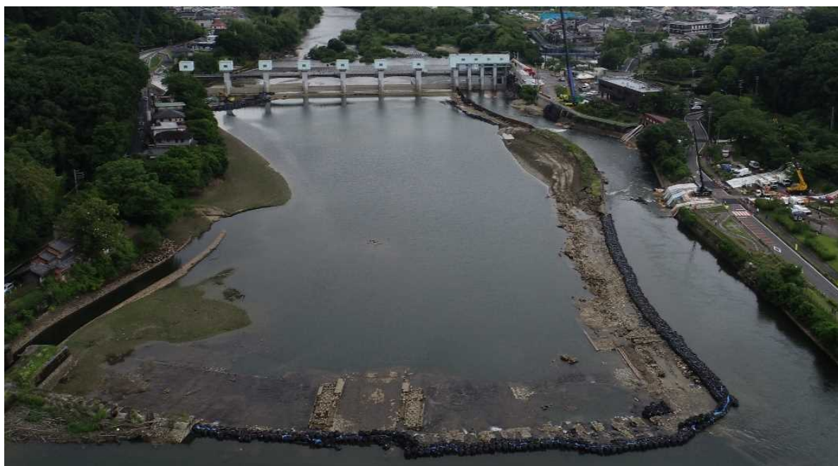
頭首工全景（上流から撮影）
