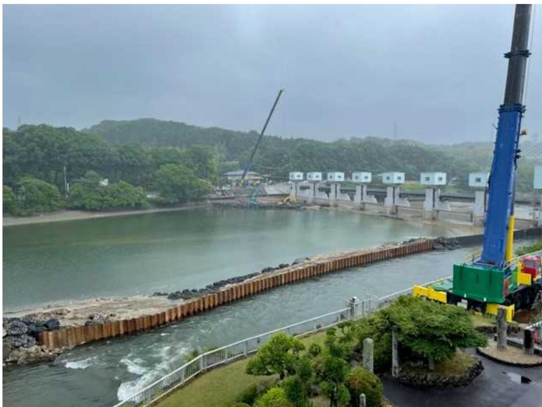
頭首工全景（管理所側から撮影）
