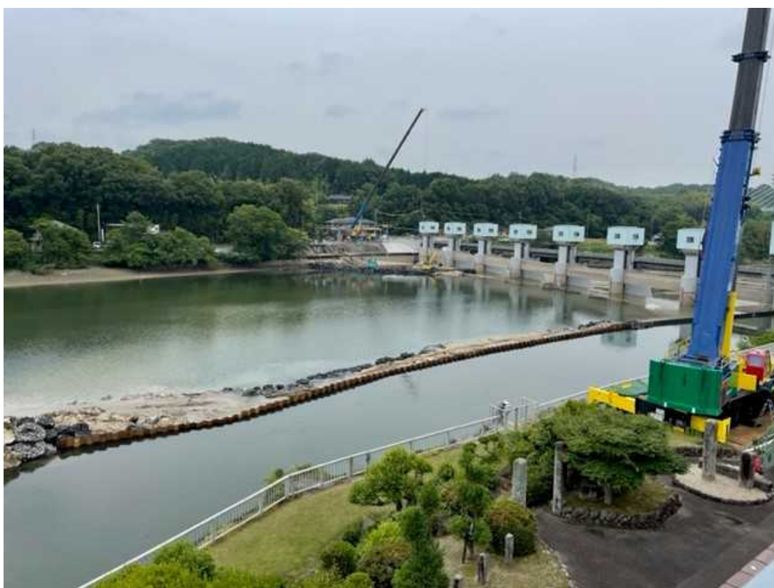
頭首工全景（管理所側から撮影）
