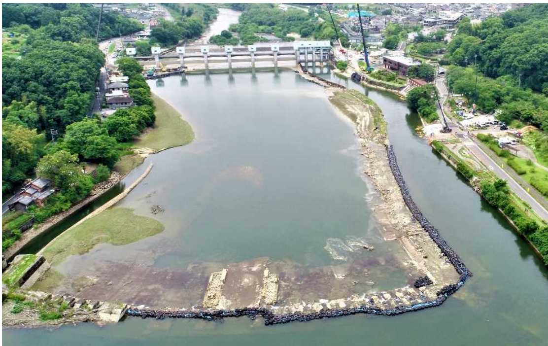
頭首工全景（上流から撮影）
