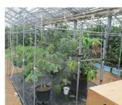
図13. 建設中のビニル
