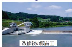
改修後の頭首工
