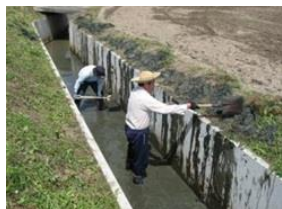
水路の泥上げ
