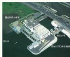
日光川河口排水機場
