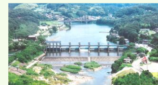
明治用水頭首工
