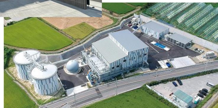
写真下： 発電施設等外観全景
