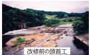
改修前の頭首工
