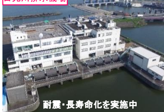
日光川排水機場
