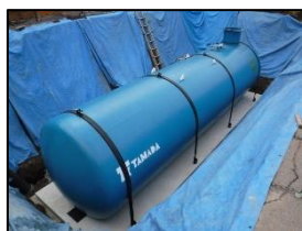
防火水槽 施工中
