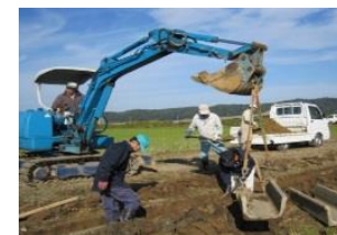
コンクリート水路の更新
