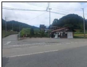
防火水槽 施工後
