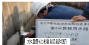
水路の機能診断
