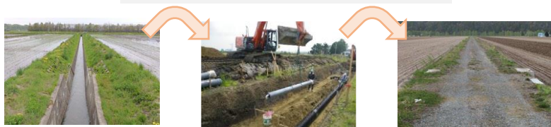
用水路のパイプライン化と農道の拡幅
