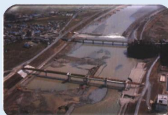
岡島頭首工 (造成時)
