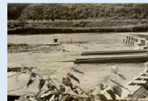
明治用水旧頭首工 (明治42年)
