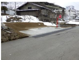
防火水槽 施工後
