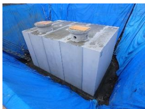
防火水槽 施工中
