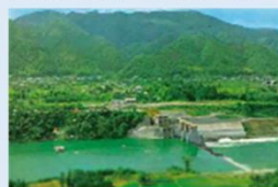
造成時の粟生頭首工
