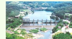
明治用水頭首工
