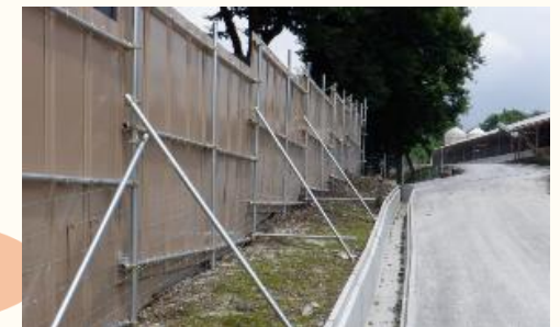
野生動物侵入防止壁の施工例
