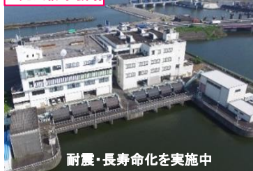
日光川排水機場
