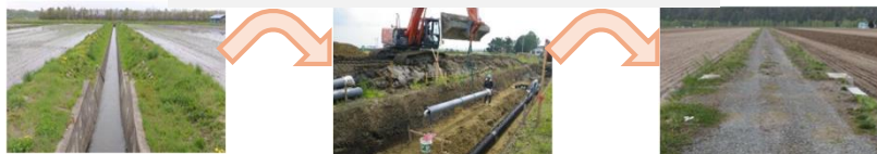
用水路のパイプライン化と農道の拡幅
