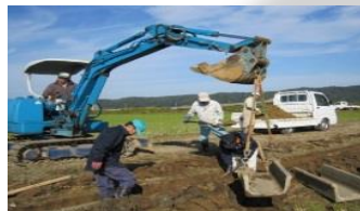
コンクリート水路の更新
