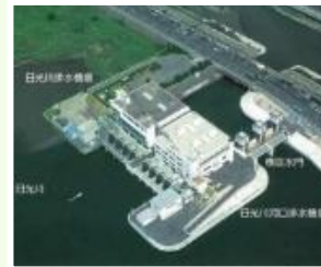
日光川河口排水機場
