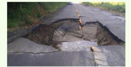
南部幹線水路
