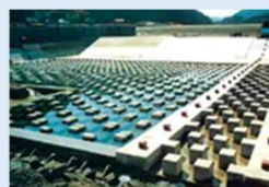
粟生頭首工護床工 (整備後)
