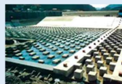
粟生頭首工護床工 (整備後)
