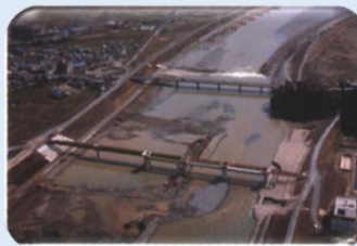
岡島頭首工 (造成時)
