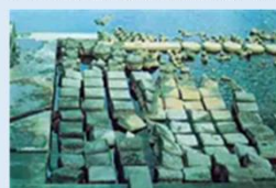
粟生頭首工護床工 (整備前)
