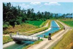
造成時の1号幹線水路
