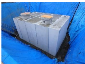
防火水槽 施工中
