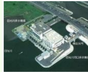
日光川河口排水機場
