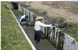
水路の泥上げ
