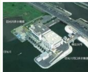
日光川河口排水機場
