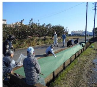
水路法面への防草シート敷設状況
