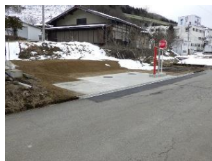
防火水槽 施工後
