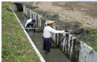
水路の泥上げ
