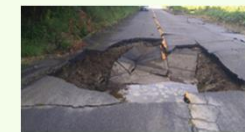
南部幹線水路
