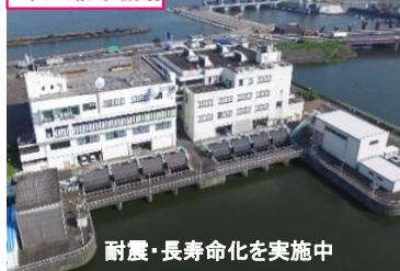
日光川排水機場
