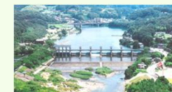
明治用水頭首工
