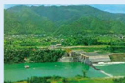
造成時の粟生頭首工
