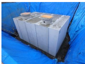
防火水槽 施工中
