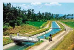
造成時の1号幹線水路
