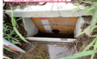
流出調整板設置の例
