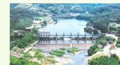
明治用水頭首工
