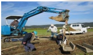
コンクリート水路の更新
