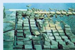
粟生頭首工護床工 (整備前)
