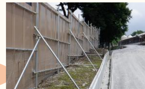
野生動物侵入防止壁の施工例
