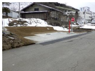
防火水槽 施工後
