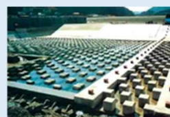
粟生頭首工護床工 (整備後)
