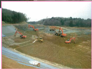
<実施中：池敷の掘削>
