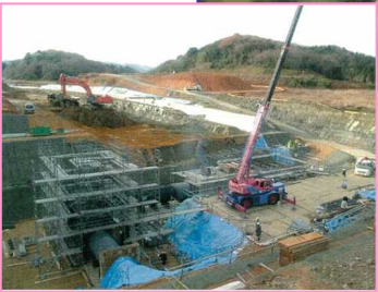
<実施中：取水工の施工>
