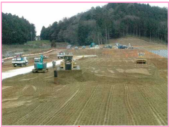
<実施中：第3副堤の盛立>
