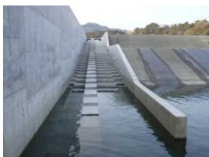
下流放流工（魚道）
