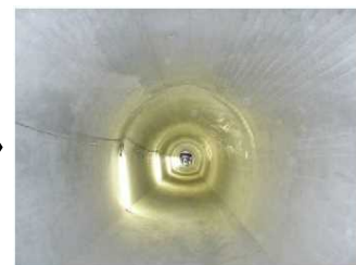
内空断面の拡幅
