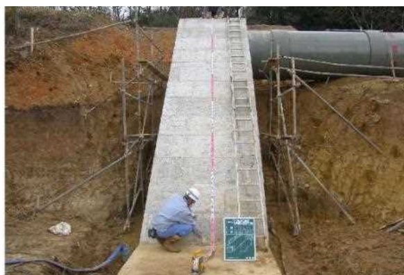
コンクリート基礎の施工
