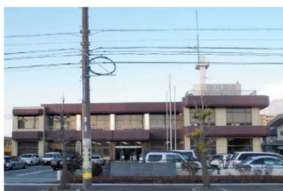
中央管理所（宮川用水土地改良区）
