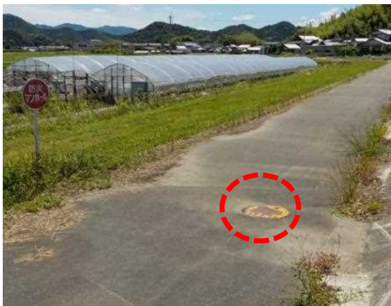
防火用マンホール（防火用水）
